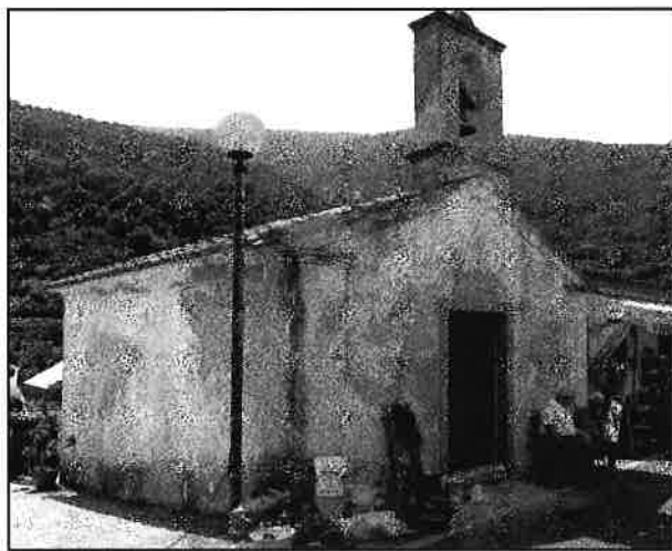
Lavori di restauro alla cappella "Assunzione di Maria" (La Zanca)
